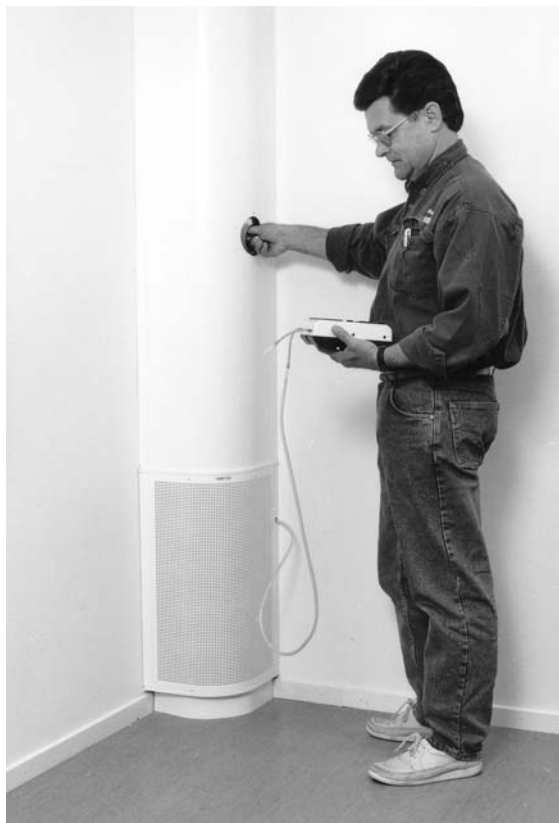
Injustering av låghastighetsdon.
