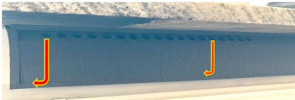
Bilden visar den felmonterade skumplasten under fönsterbänken. Luften bör gå i pilarnas riktning: uteluften kommer in upptill, går ned genom vertikala hål och ut till rummet nedtill. Men för att det ska fungera måste skumplastinsatsen vridas horisontellt 180 grader!
