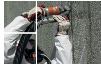
Foto från "Inventering och sanering av PCB i byggnader och anläggningar" ( Naturvårdsverket 2019 )
